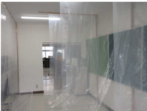
待機室を多目的室に設営しました。ビニルシートで部屋を半分に仕切り、さらにシートで3つの小部屋に仕切りました。
