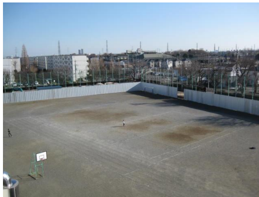
仮設校舎建設のため校庭に仮囲いを設置
